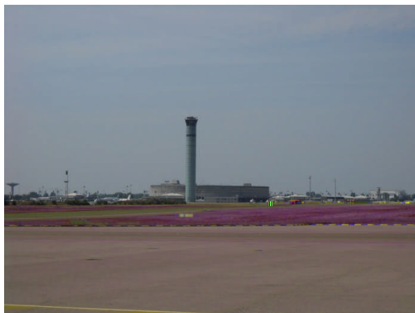
Figure 1: Terminal 1 et Tour de contrôle de l'aéroport Paris-Charles de Gaulle
